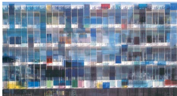
Abb. 28 Durch die Tiefenstaffelung und unterschiedliche Farbigkeit wird die Fassade für Vögel als Hindernis sichtbar. Novartis Campus in Basel. 2005. Architekten: Diener & Diener, Basel. Künstler: Helmut Federle & Gerit Wiederin.
