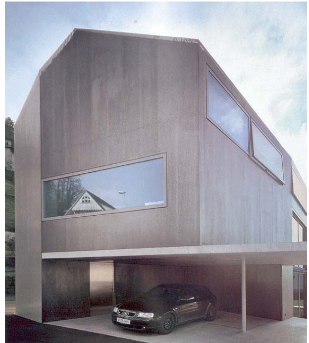
Abb. 4 Gefahr durch spiegelnde Fensterflächen. Wohnhaus in Dornbirn. Architekten: Oskar Leo Kaufmann & Albert Rüt, Dornbirn.
