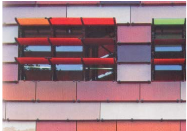
Abb. 26 Da die farbigen Gläser opak, kleinflächig und reflexionsarm sind, sind sie für Vögel gut erkennbar. Polizei- und Feuerwache in Berlin. 2004. Architekten: Sauerbruch & Hutton.
