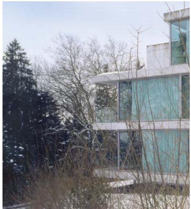
Abb. 6 Gefahr durch transparente Geländer und durchsichtige Fensterecken. MFH an der Forsterstrasse in Zürich. Architekt: Christian Kerez, Zürich.
