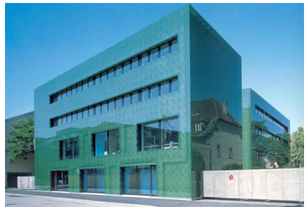
Abb. 5 Gefahr durch spiegelnde Fassadenverkleidung. Apothek des Kantonsspitals Basel. Architekten: Herzog & de Meuron, Basel.
