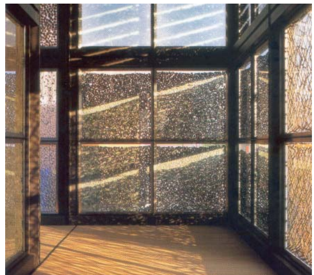
Abb. 40 Durch Materialkombinationen entstehen lichtdurchlässige, vogelschutzfreundliche Fassaden, die durch ihren spezifischen Ausdruck überzeugen. Christus-Pavillon an der Expo Hannover. 2000. Architekten: Gerkan, Marg & Partner.
