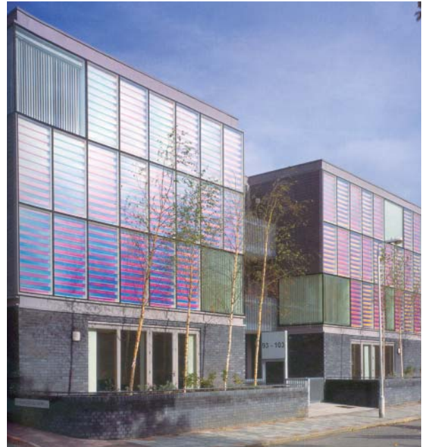
Abb. 39 Der Gestaltungsspielraum ist riesig: lichtreflektierende Folienstreifen zwischen den Gläsern ergeben einen reizvollen Vogelschutz. MFH Peabody in London. 2004. Architekten: Niall McLaughlin.
