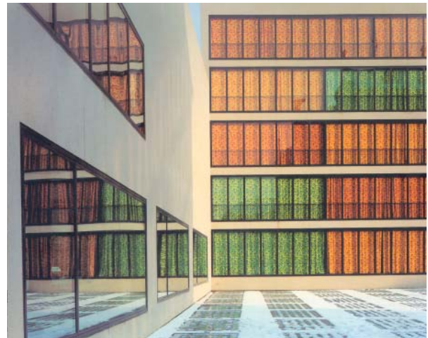
Abb. 29 Vorhänge als Vogelschutz. Nur wirksam in Kombination mit Tagvorhängen oder in zugezogenem Zustand. Überbauung Dreirosen-Klybeck in Basel. 1993 -1996. Architekten: Morger & Degelo, Basel
