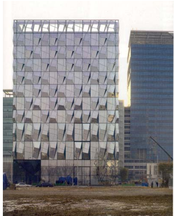
Abb. 19 Mischung aus Sprossen und Neigungen. Trutech Building in Seoul. 2006. Architekten: Frank Barkow, Regine Leibinger, Berlin & Chang-Jo Architects, Seoul.
