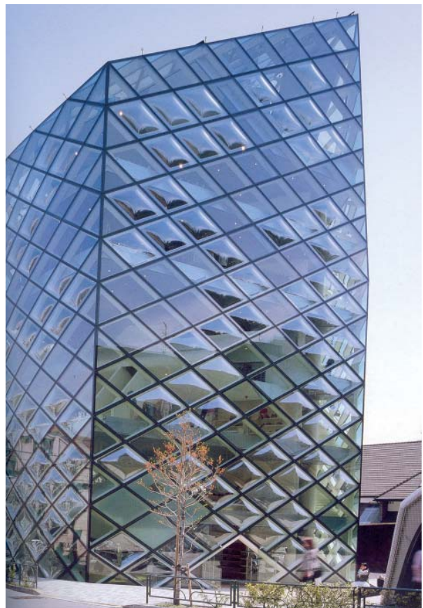
Abb. 16 Bombierte Glasfassade. Prada Flagshipstore in Tokio. 2000 - 2003. Architekten: Herzog & de Meron, Basel.
