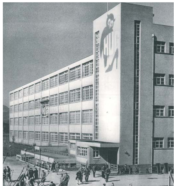
Abb. 11 Denkmalgeschütztes Gebäude mit klassischer Sprosseneinteilung. Schuhfabrik Hug in Dulliken. Bild ca. 1930. Architekt: Robert Schild.
