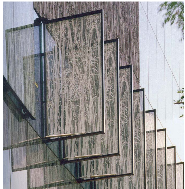
Abb. 21 Siebdruck mit abstrahiertem Naturmotiv. Bibliothek der Universität in Utrecht, Niederlande. 2004. Architekt: Wiel Arets, NL.
