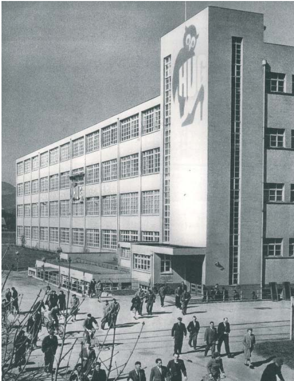
Abb. 44 Schuhfabrik Hug in Dulliken. Bild ca. 1930. Architekt: Robert Schindler.
