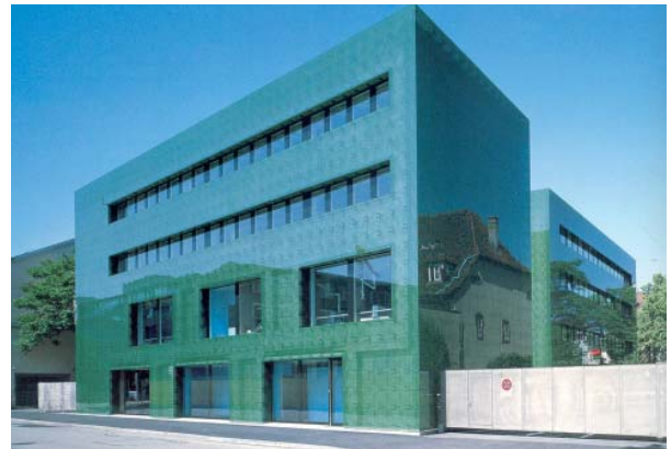
Abb. 45 Apotheke des Kantonsspitals in Basel. 1998. Architekten: Herzog & de Meuron, Basel.
